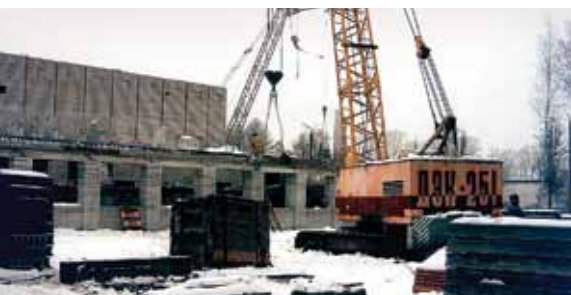
Строительство радиотерапевтического корпуса, 2007 год
