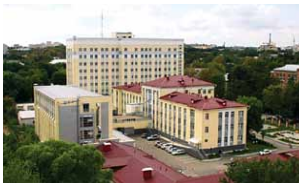
Современный комплекс зданий онкодиспансера
